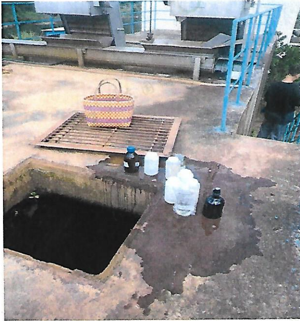
污水厂进水口
